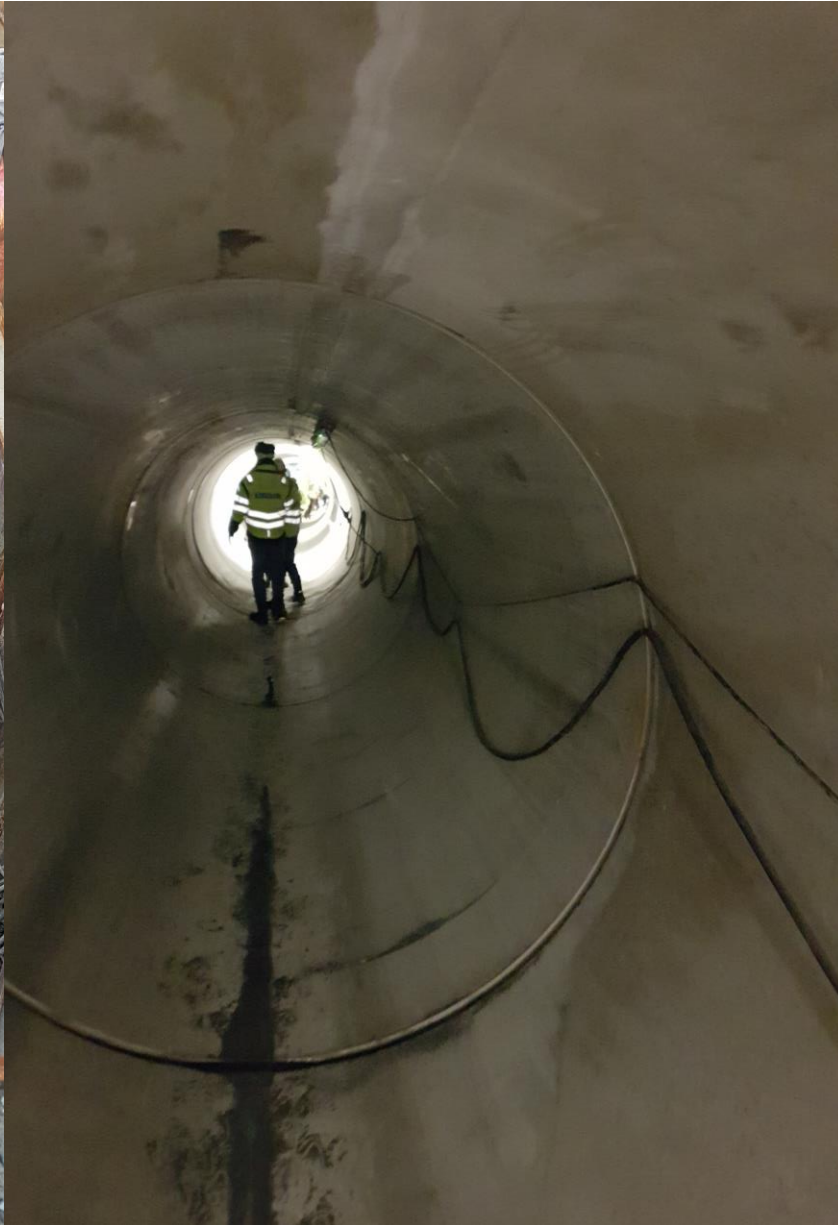
spasertur i 2000mm rør
