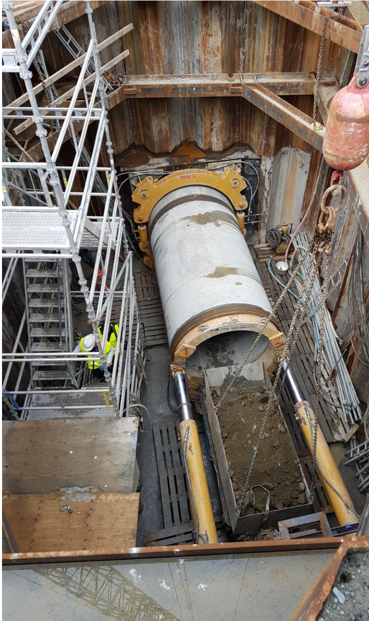
Tunnelering i 12 m dyp
